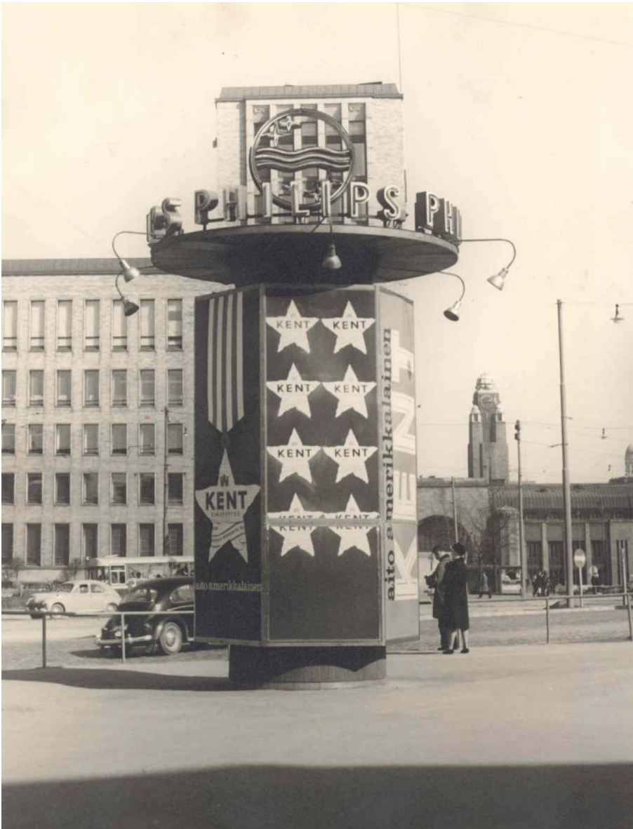
Mainospylväs Arkadianaukiolla. Kuva rakennusvalvontaviraston arkisto vuodelta 1965
